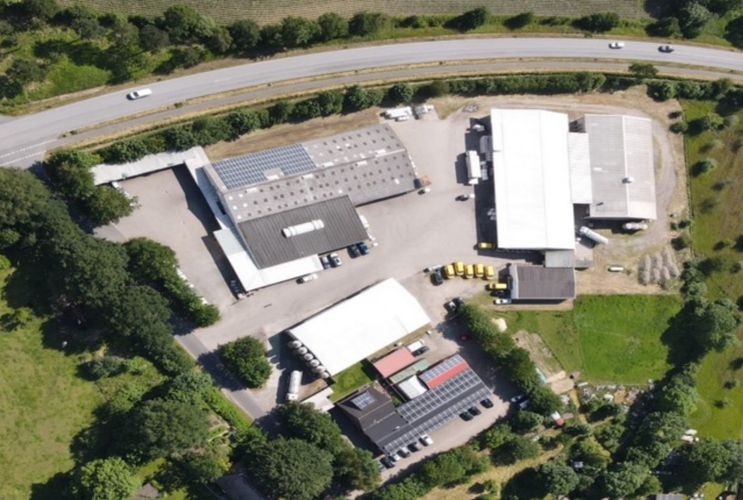
Luftbild Röschmann Landhandel GmbH Betriebsgelände an der B430 nahe A23 Ausfahrt 7 Schenefeld
